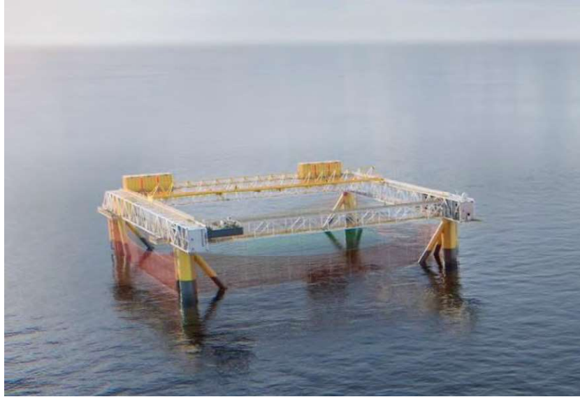
Botadura en su posición de una instalación Offshore
