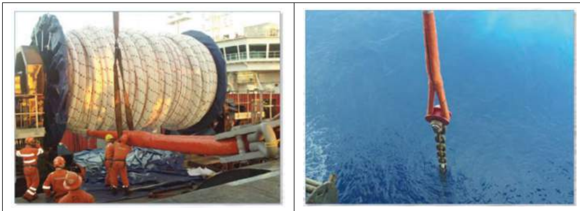
Figura 56. Terminales conexión entre cabo-cadena para fondeo. Preparación a bordo de embarcación de instalación (izq.) y resultado final de la unión del cabo de poliéster de alta resistencia a la cadena (drcha.)
