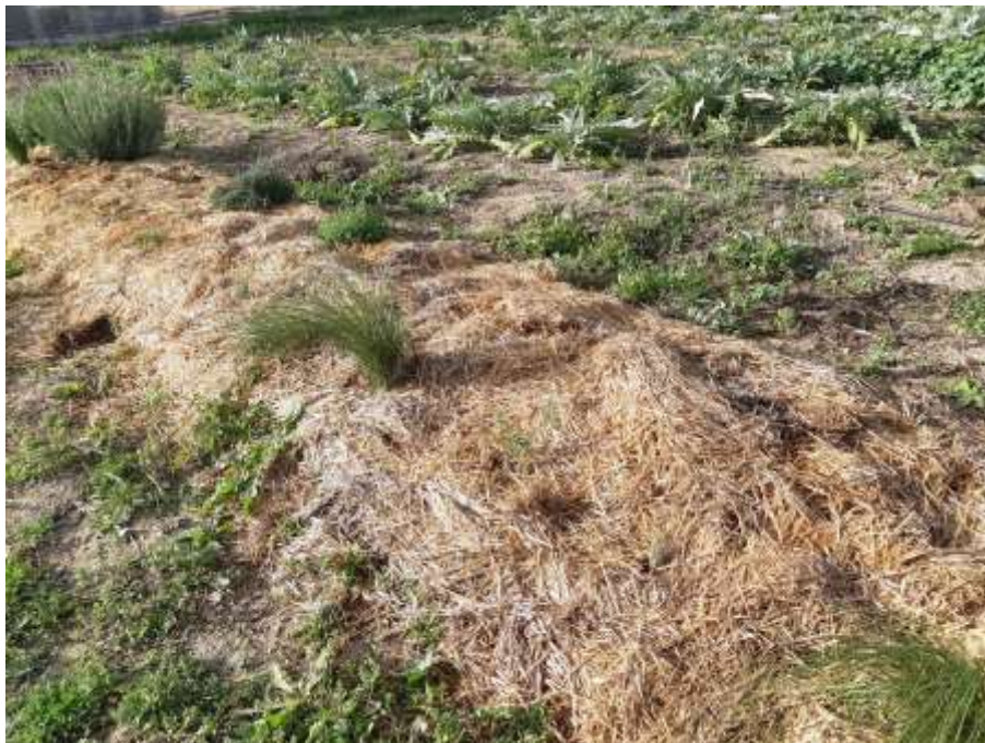
Foto nº 30. Prevención de erosión con mulching de paja en la meseta de la EVC (11/12/2019).
