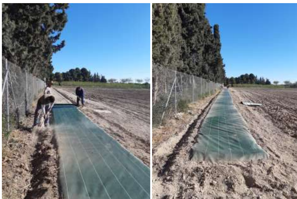
Foto nº 21. Colocación de malla antihierba de polifibril en meseta (14/03/2019).
