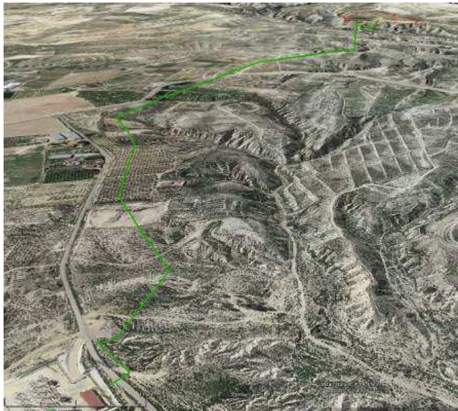
Panorámica del trazado de la línea desde la subestación hasta la planta.
