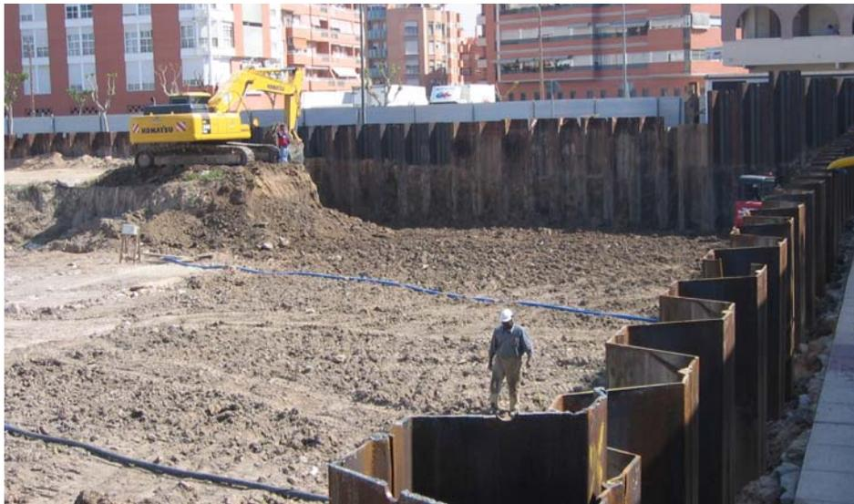
La excavación implica el vaciado del terreno en profundidad y lleva aparejada la existencia de paredes en el terreno, que normalmente necesitan ser sostenidas. Es una fase en la que tienen una gran importancia las características del terreno, pues algunas de las medidas de seguridad establecidas dependen del tipo y condiciones del terreno. Pero,
