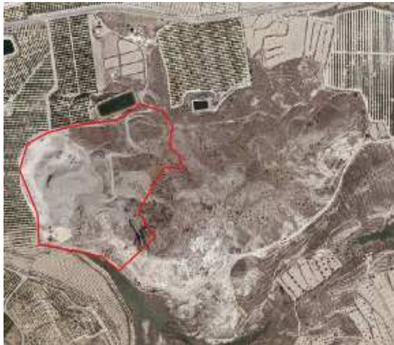
Figura 6. Ortografía del año 2007 . Aumentando la superficie afectada por la actividad extractiva dentro del perímetro solicitado.
