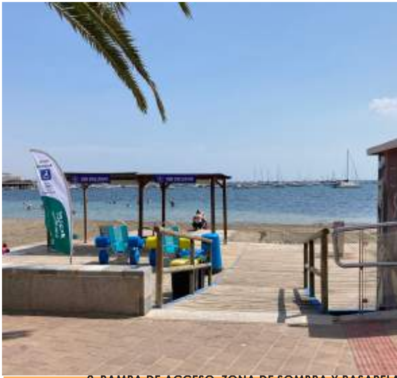
2_RAMPA DE ACCESO, ZONA DE SOMBRA Y PASARELA
