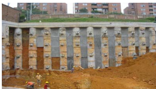
Fig. 16 Pantalla discontinua anclada
