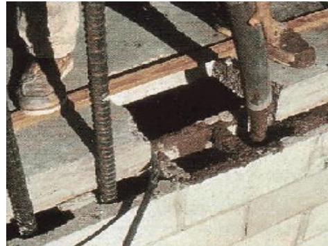
Fig. 18 Muro de Prefabricados de hormigón
