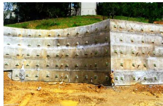
Fig. 19 Anclaje en muros
