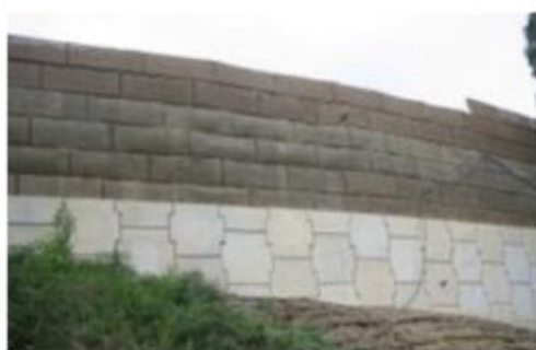
Fig. 20 Muro de tierra Armada
