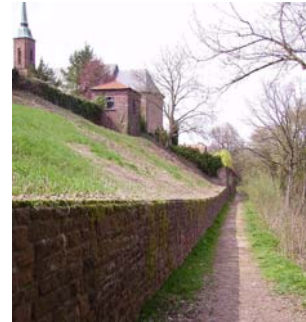
Fig. 13 Muro de contención
